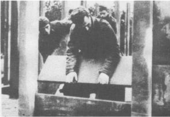
Hier werden die kalten und schweren Betonplatten eingesetzt
