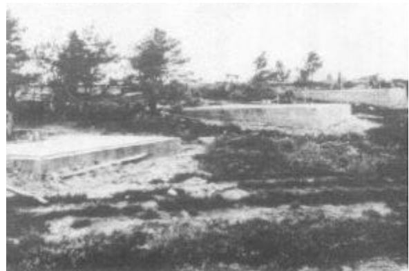
Hier die ersten Fundamente
